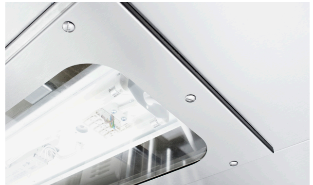
Glasluckan som skyddar den infällda belysningen är fastskruvad i kåpens tak
