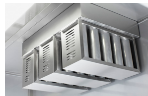
Cyklotec består av ett filterhus med filterkassetter. Varje kasset innehåller tio cykloner
