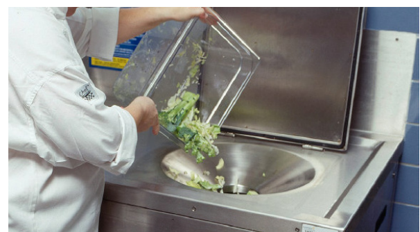
Inkastbänk i rostfritt stål
