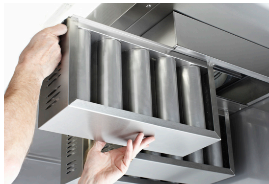
Filterkassetten skjuts in i filterhuset
