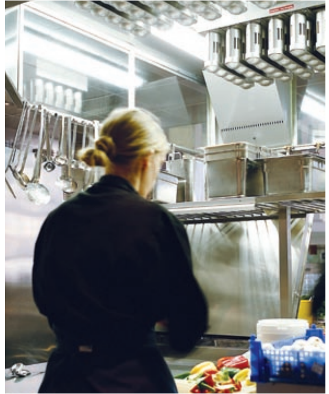
UV Combilux-filtret är monterat i kökskåpens tak
