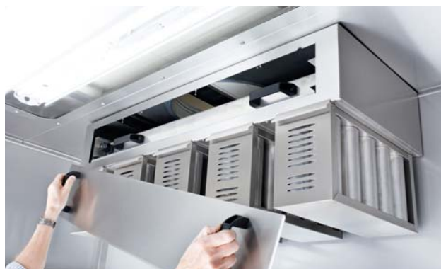
Figur 4 - När samtliga filter är monterade i filterhuset, stängs inspektionsluckan
