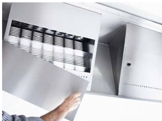
Figur 3. På insidan av Sefokåpa E, bakom tilluftsdonet, finns tilluftshuset. Inspektionssluckan öppnas endast vid finjustering av luftflödet eller invändig rengöring
