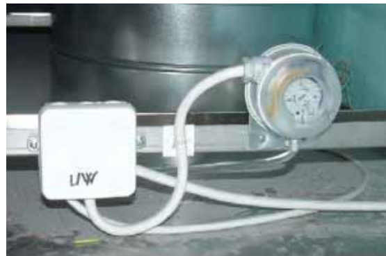
Monterad tryckdifferensbrytare utanpå kåpan i lodrätt läge.
