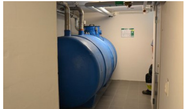
Lagringstank i armerad glasfiber.
