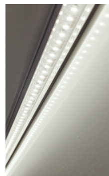
LED-belysning längs hela volymkåpans bredd.
