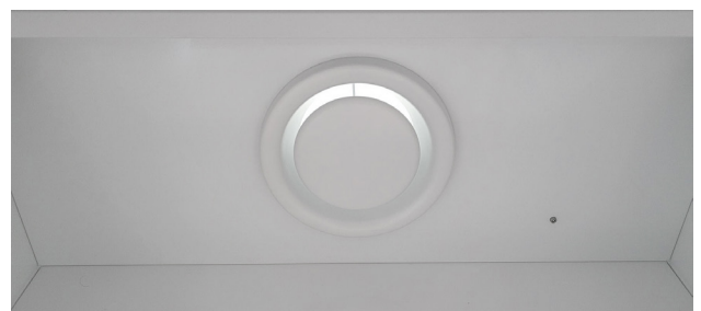
Kontrollventil 125 mm
