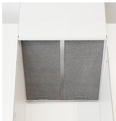
Fettfiltret placeras diagonalt i skåpkåpans överdel.
