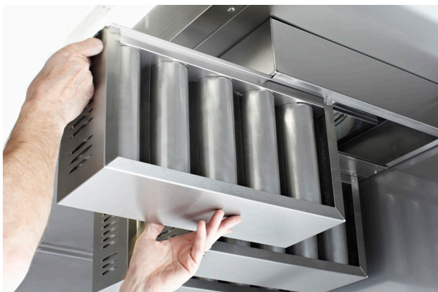
Filterkassetten skjuts in i filterhuset
