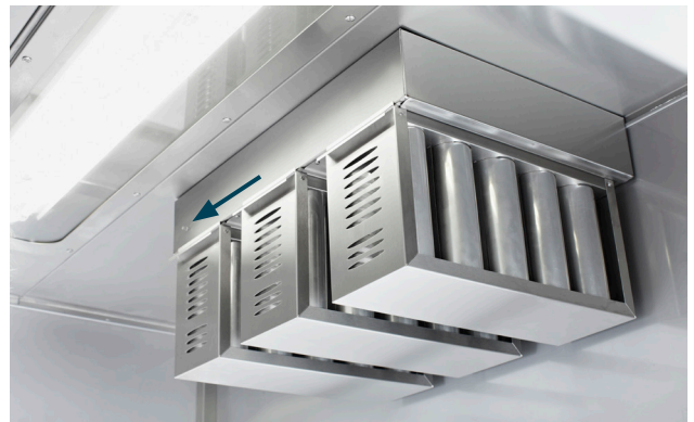
Cyklonfiltrets mätuttag finns överst till vänster (se pil) på filterhuset
